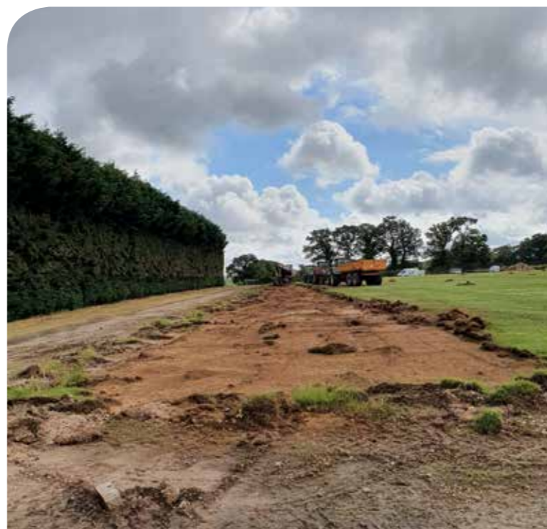
1- Décaissement et évacuation des terres
