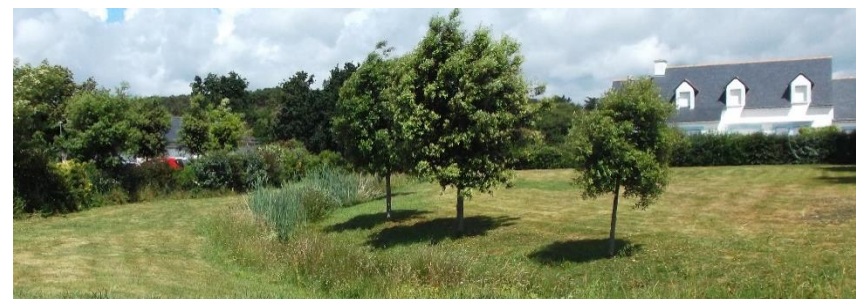
Exemple de gestion des eaux pluviales en aérien, espace public en centre-bourg. Saint-Philibert (56)
