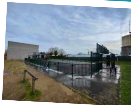
Construction d'un city stade esplanade de La Gare
