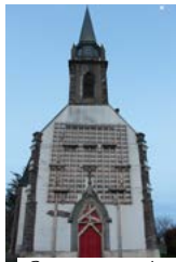
Sécurisation réalisée sur l'église St-Raoul
